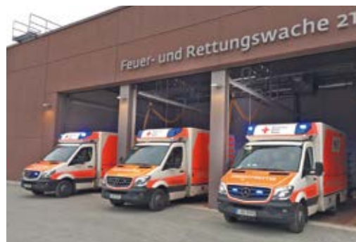
Die Fahrzeughalle der neuen Rettungswache 21. Foto: Stefan Pollet
